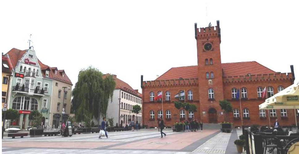
Fot. 72. Budynek ratusza dominujący przestrzeń placu Wolności
