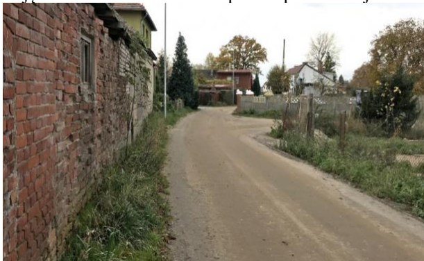
Zdjęcie 5. Ulica Letniskowa - przed i po realizacji
