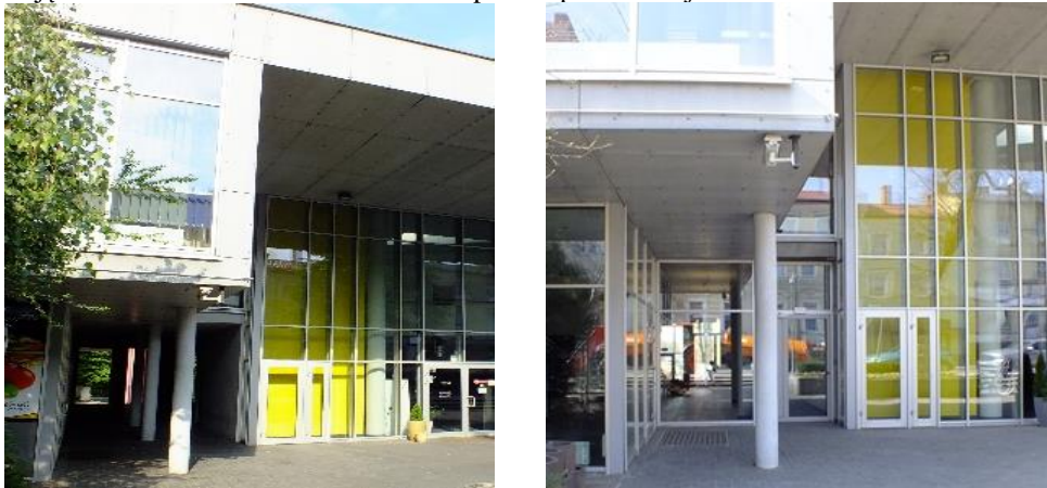
Zdjęcie 7. Przebudowa Kina Wolność – przed i po realizacji
