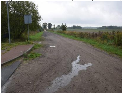
Zdjęcie 3. Ulica B. Prusa - przed i po realizacji
