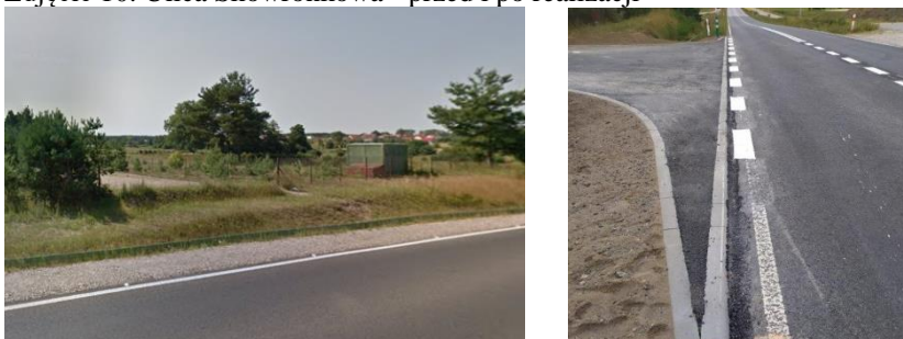
Zdjęcie 10. Ulica Skowronkowa - przed i po realizacji
