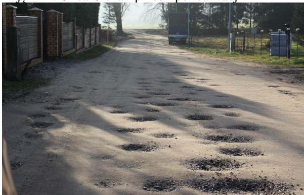
Zdjęcie 4. Ulica Cicha - przed i po realizacji
