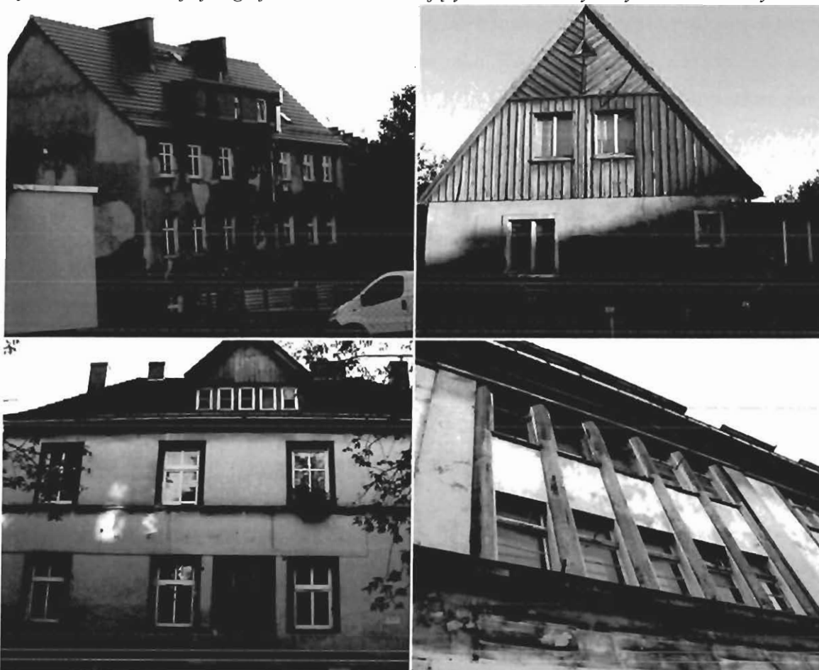
Ryc. 59. Dokumentacja fotograficzna – niezadowolający stan techniczny budynków mieszkalnych
