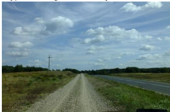
Zdjęcie 12. Droga rowerowa – przed i w trakcie realizacji
