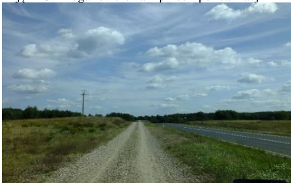
Zdjęcie 3. Droga rowerowa – przed i po realizacji
