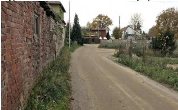
Zdjęcie 14. Budowa odcinka ul. Letniskowej – przed realizacją
