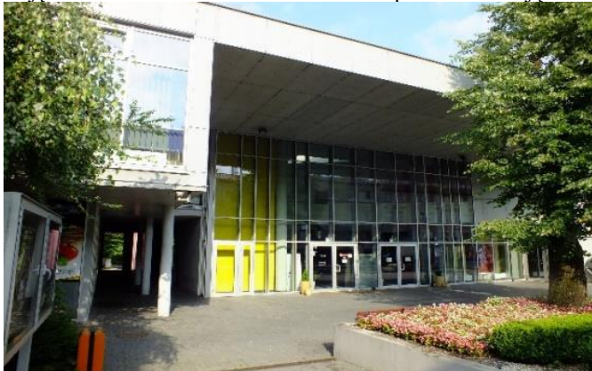
Zdjęcie 15. Przebudowa kina Wolność – przed realizacją
