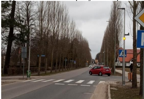
Zdjęcie 7. Doświetlone przejścia dla pieszych
