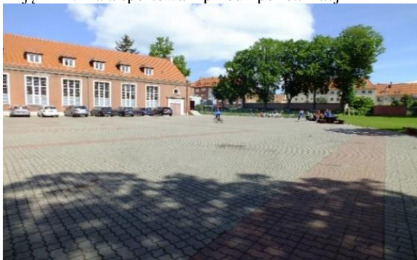
Zdjęcie 4. Hala sportowa – przed i po realizacji
