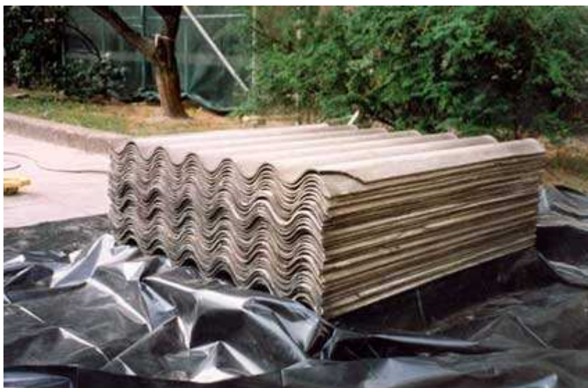
Rysunek 5 Przygotowanie wyrobów azbestowych do transportu:
