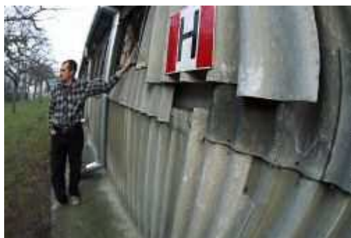
Rysunek 7 Ściana boczna budynku z płyt cementowo-azbestowych:
