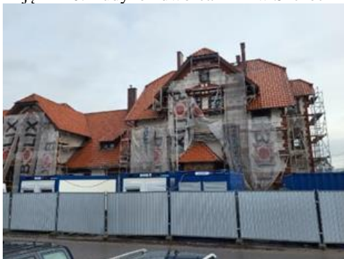
Zdjęcie 10. Budynek dworca PKP w Szczecinku – w trakcie realizacji
