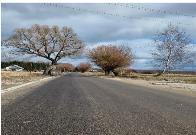
Zdjęcie 14. Ulica Rybacka - w trakcie realizacji
