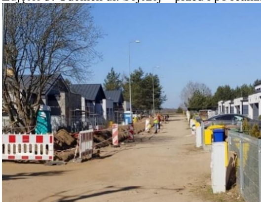
Zdjęcie 3. Odcinek ul. Sójczej – przed i po realizacji
