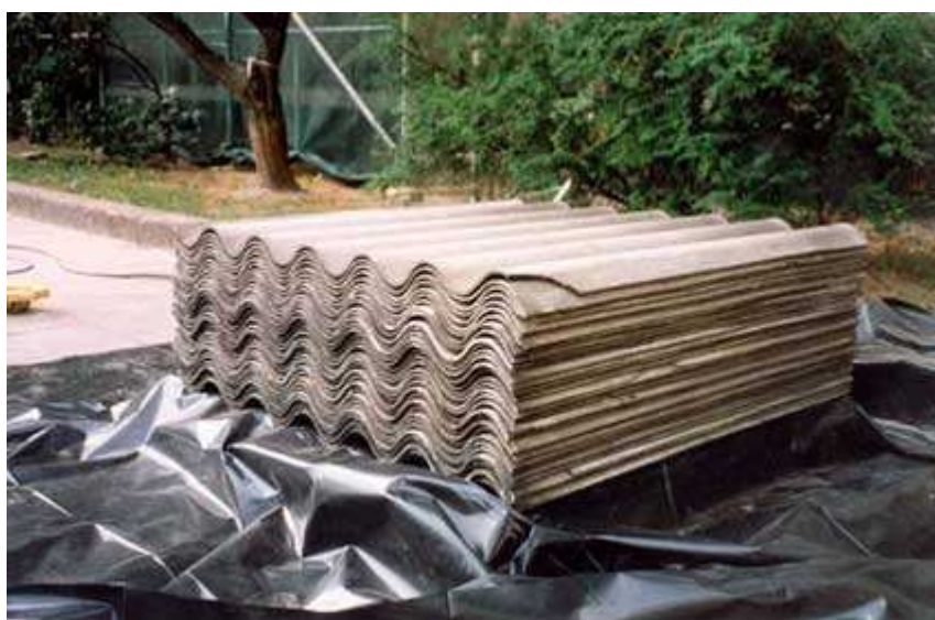
Rysunek 5 Przygotowanie wyrobów azbestowych do transportu:
